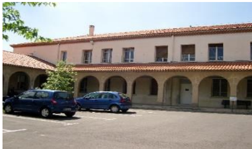
Bâtiment principal site Poncet
