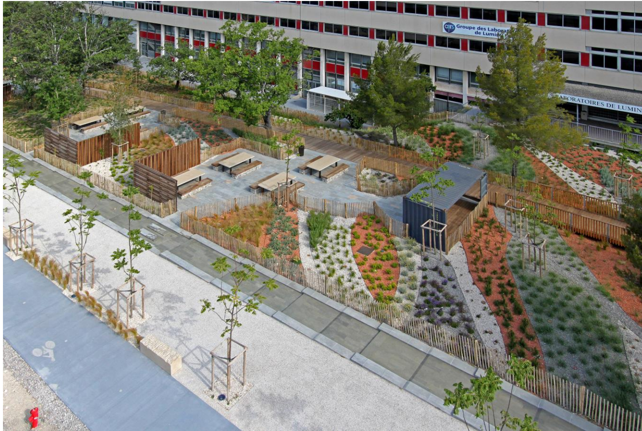
ANR 2012 – aménagement des espaces extérieurs deuxième tranche
